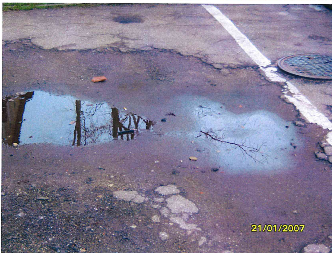
Widoczne ubytki nawierzchni asfaltowej
