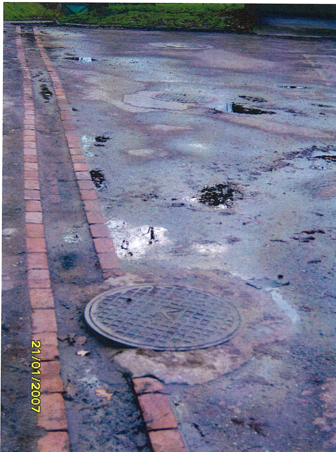
Widoczny niedrożny rynsztok oraz zespół 3 wjazdów - połączenie uszczelniono betonem
