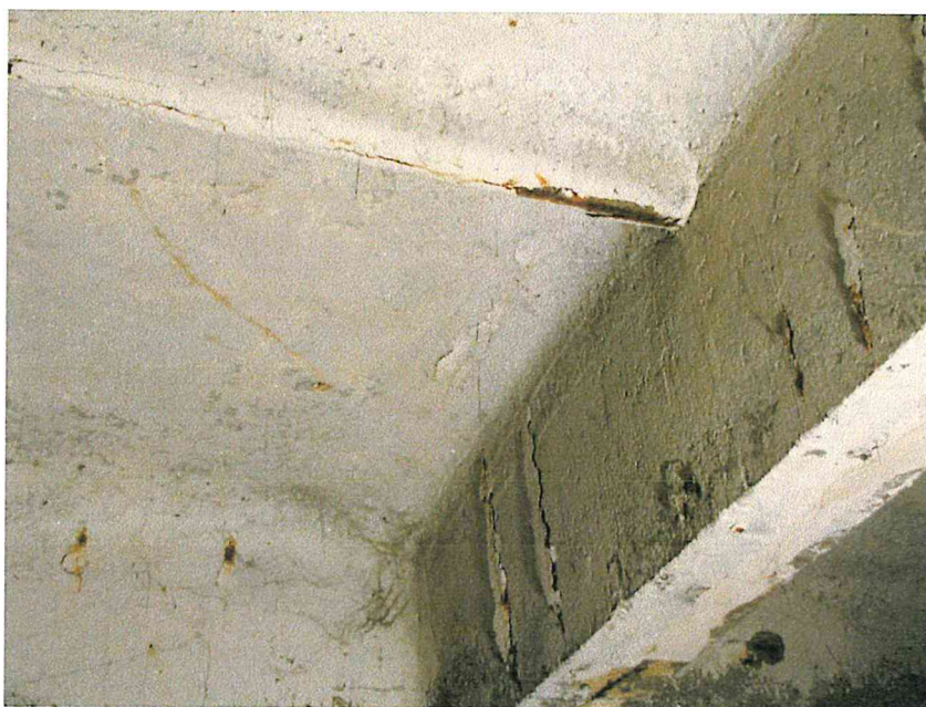
Zdj. Nr 2 Proces korozji stali w płytach stropowych spowodował „odepchnięcie” betonu w ściankach pionowych i żebrach.
