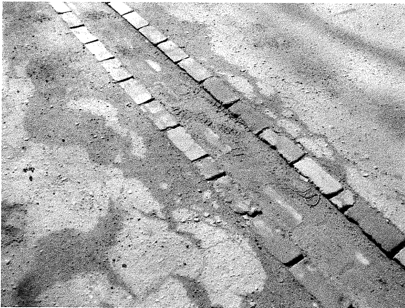
Zdj. nr 8 Stan techniczny koryta odwadniającego, które nie posiada właściwego spadku podłużnego.
