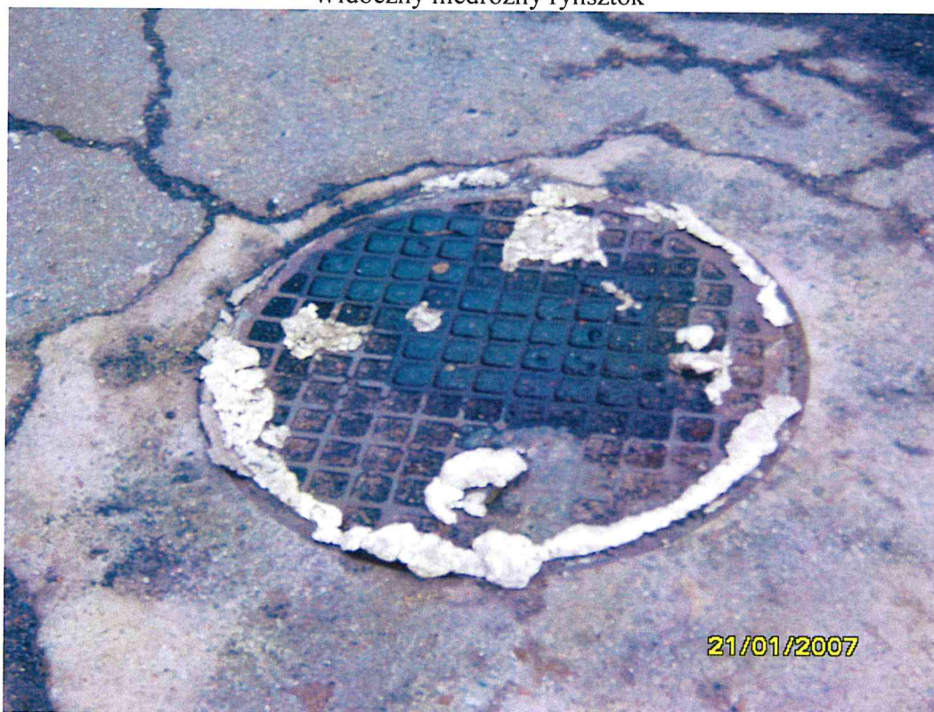
Widoczna próba uszczelnienia wjazdu
