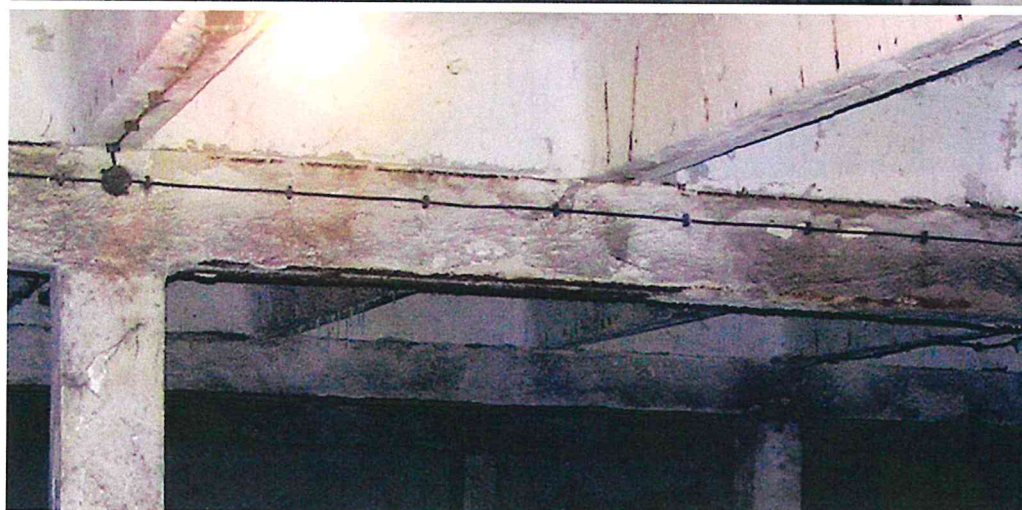
Widoczne „sople” i korozja podciągów
