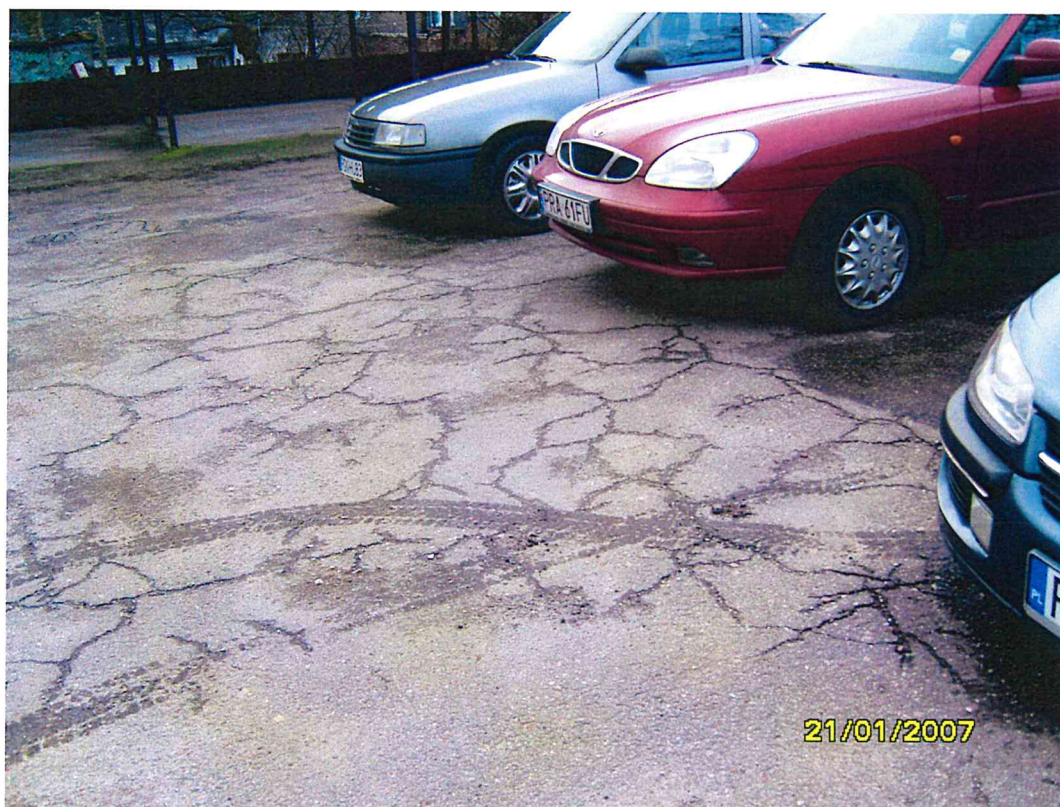
Widoczne spękania nawierzchni asfaltowej
